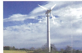
⑤ 風力発電施設
